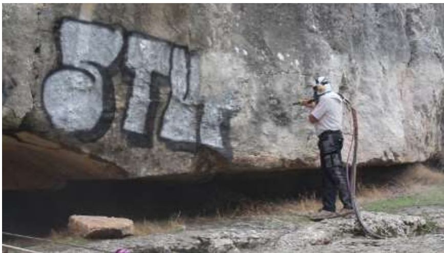
Effacement du tag par la technique d'aérogommage
