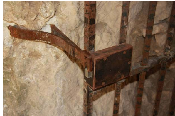
La serrure d'une des grilles fermant le tunnel d'accès à la grotte a dû être totalement remplacée
