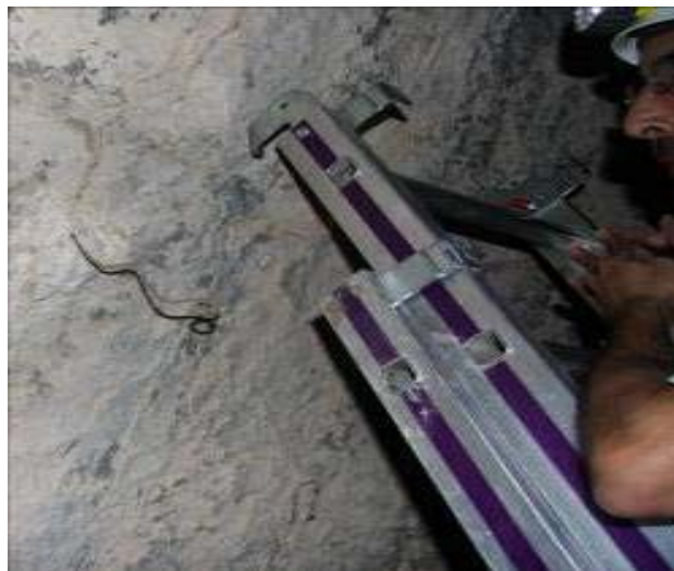
Retrait des restes de fil de fer dépassant des parois
