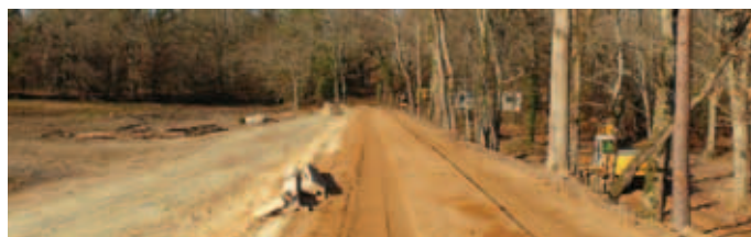
Réfection de la digue
