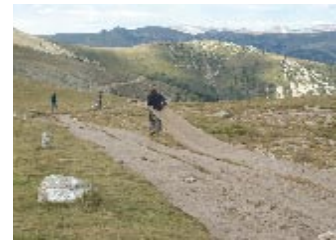
Pose de géotextile
